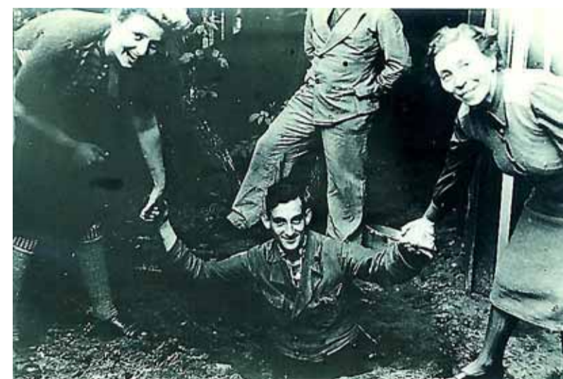
Onderduiker Daan Grunwald komt uit gang Larense villa.
